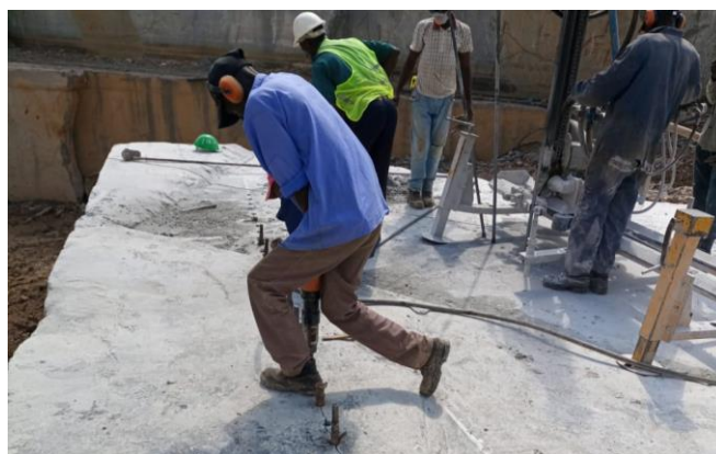
Figura 14: Perfuração dos blocos usando uma broca pneumática
